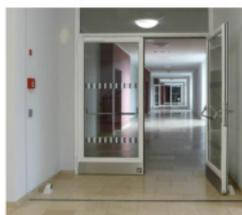
Rauchschutztür mit Feststellanlage – automatische Schließung im Brandfall
