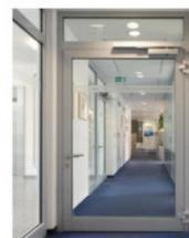
Freilauf-Türschließer – nur im Brandfall aktiv, im Normalbetrieb ohne Kraftaufwand zu öffnen
